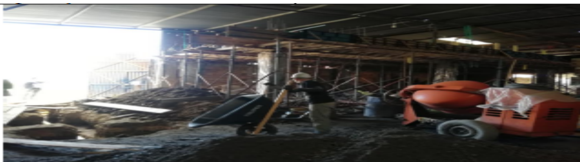
Fotografía No.9: Obra dentro del predio.
